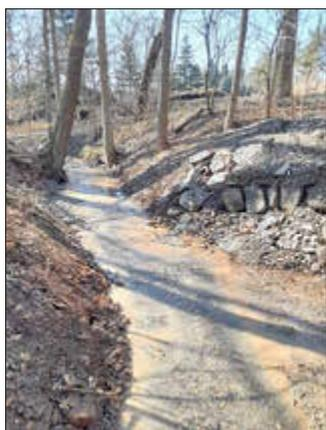
Weiter erfolgten Arbeiten an der Gewässerunterhaltung. So wurde am Dorfbach Schilbach Sedimentablagerungen entfernt und der Bachlauf profiliert.
